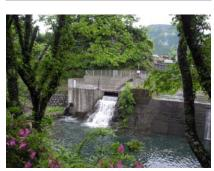
小水力発電所は、わずか6メートルの川の落差を利用した発電です。四万十川の源流で豊かな水が電力を生んでいます。取水量は、1.2トン/秒。年間の発電量は、262MWH。昼間は小中一貫校「梼原学園」の電力(中学校で使用する電力の9割を発電)に、夜間は町中にある82基の街路灯の電力に使用している、ということです。もちろん余った電力は、四国電力に売っています。
