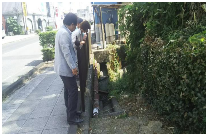
綾野地域の用水路の調査
