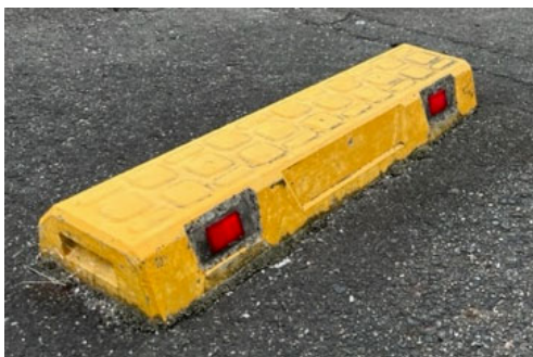
上写真は最近設置された「車止め」。目立つように黄色のペンキや反射板が設けられています。
