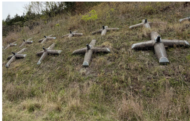
写真Ⅱ地すべり対策のグラウンドアンカーが、新名神高速道路に隣接する側道に施工されている。
